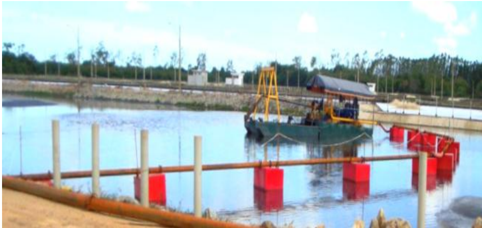
图 3-1-2 绞吸船及浮管输送工程实例照片
