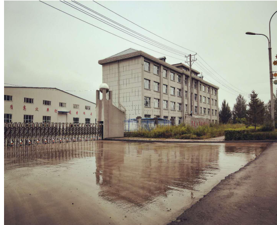
厂界西侧黑龙江德顺管业
