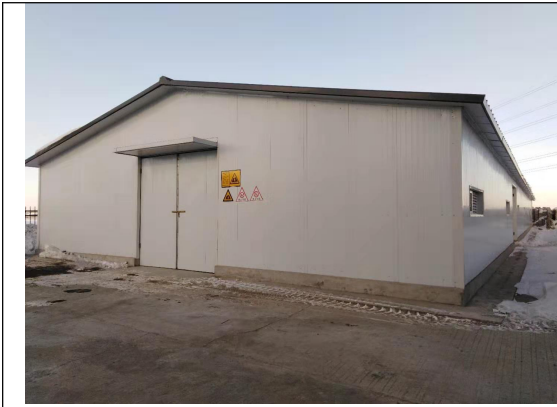
危险废物暂存间外观
