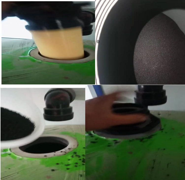
活性炭更换过程
