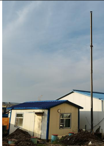
污水处理站站房及 15m 高排气筒
