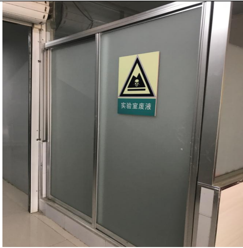
医疗废物暂存间
