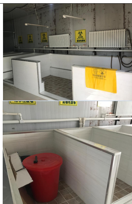
医疗废物暂存间
