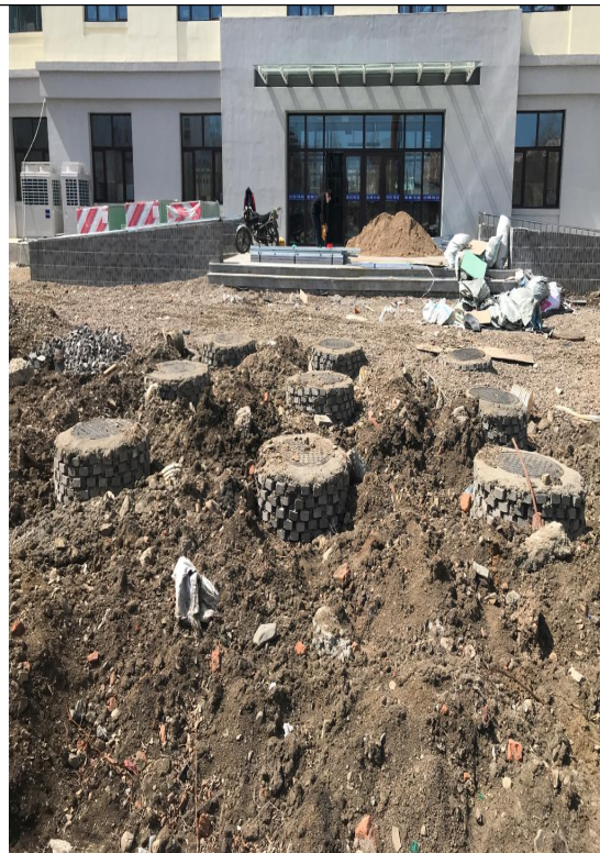
事故池检查井（地下为事故池）
