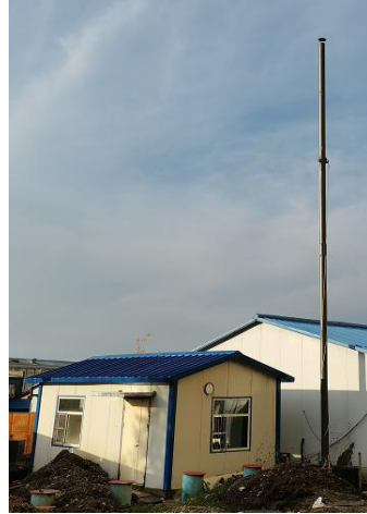
污水处理站站房及 15m 高排气筒
