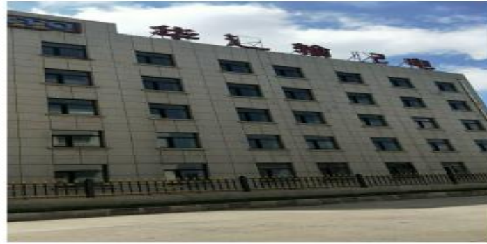
南侧黑龙江省华通输配电设备有限公司
