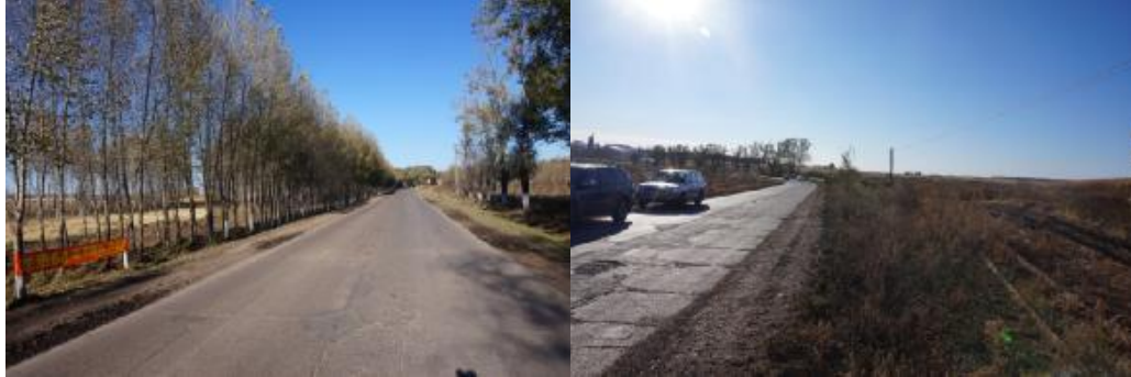
图 3.1-1 原有水泥混凝土路面现状
